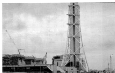
火力発電所 荒浜より
