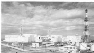
柏崎刈羽原子力発電所
