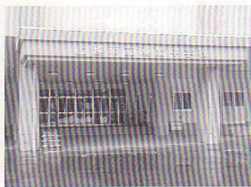
▲ 現校舎の正面玄関
