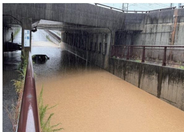
【市道国府西本町線（アンダーパス）】 道路の低いところが冠水し、車が水没しています
