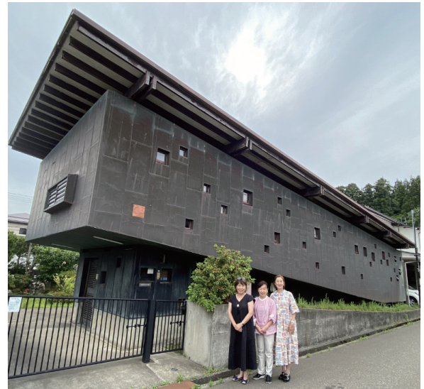
斜めの家外観
